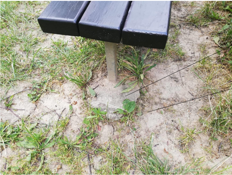
Odstranění stávající základové patky Ø 50 mm, hloubka 700 mm (předpoklad)
